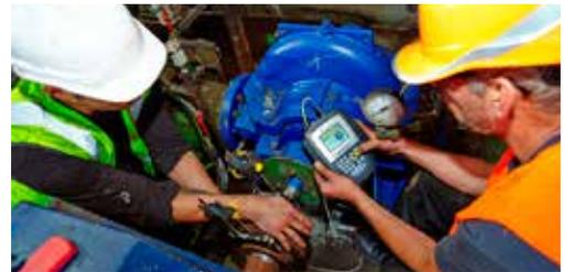
Nous réalisons également l'alignement d'arbres au laser des ensembles pompes/moteurs.
